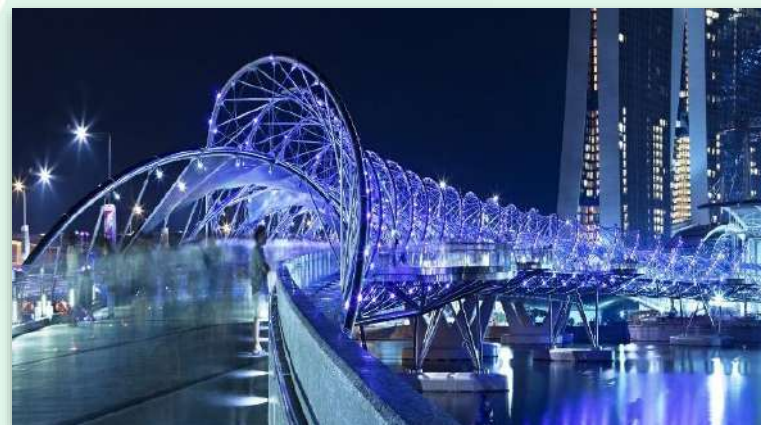
Helix Bridge, Сингапур
