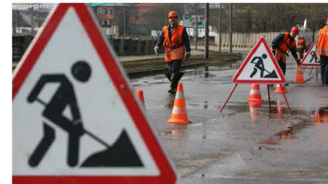
укладка асфальтобетонной смеси
