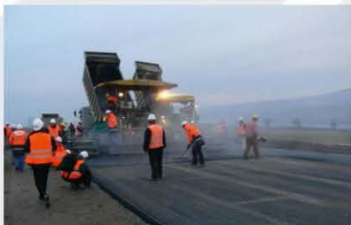
укладка а-б смеси
