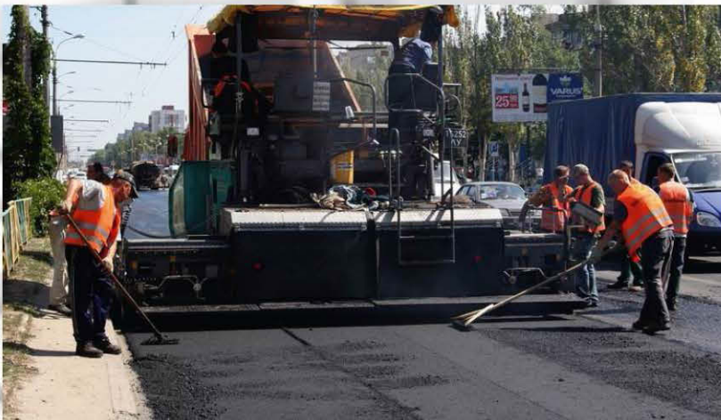
укладка асфальтобетонной смеси
